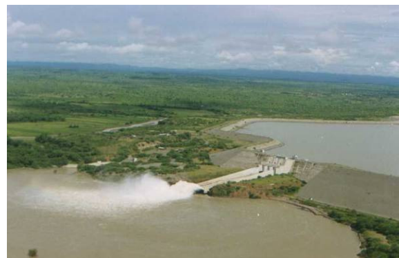
Figura 2.-Vista aérea del bloque central de la presa Poechos con aliviadero de compuertas en operación durante avenidas
