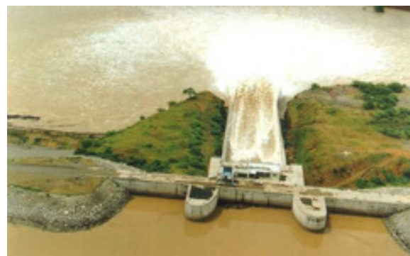
Figura 3.-Vista aérea del bloque central de la presa Poechos con aliviadero de compuertas en operación durante avenidas
