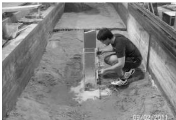
Figura 1.- Montaje de estructura
