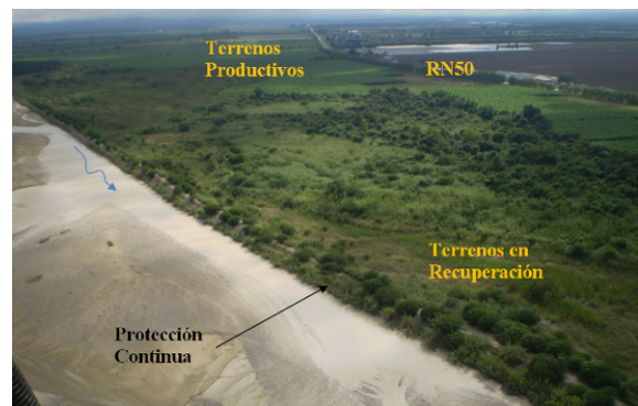
Figura 3.- Protección Continua – Margen Izquierda.
