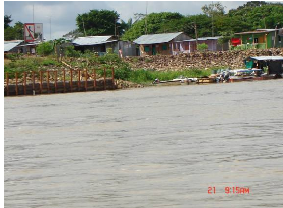
Figura 7.- Cortina de Pilotes y Enrocado
