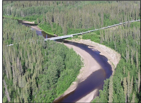
Figura 1.- Arroyo Hess durante estiaje. La dirección de flujo es desde abajo hacia arriba. El oleoducto cruza al arroyo en la parte central de la fotografía.
