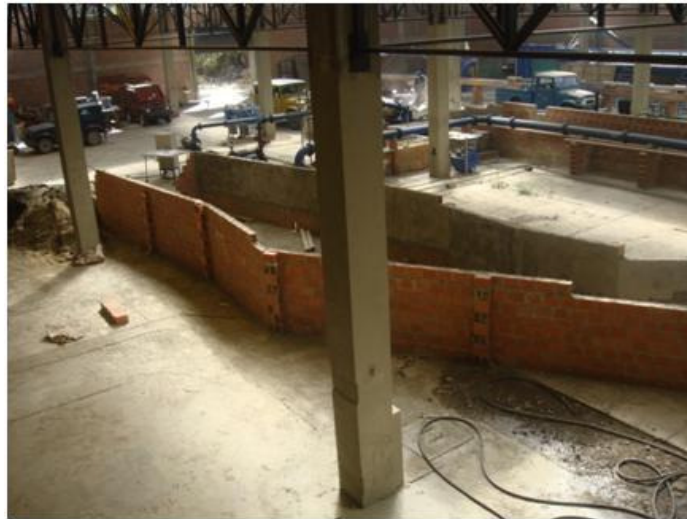
Figura 3. Tanque de mampostería de ladrillo para el modelo, Julio de 2010
