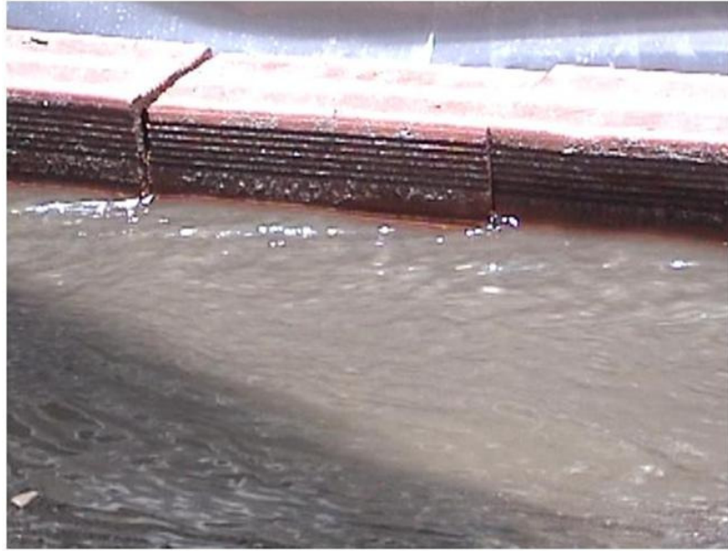
Figura 8. Las discontinuidades de la pared generan ondas
