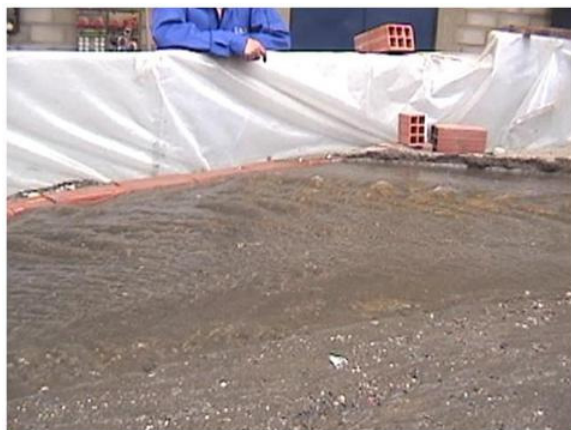
Figura 13. Ataque inicial y desborde sobre el muro en el sector de arranque aguas arriba
