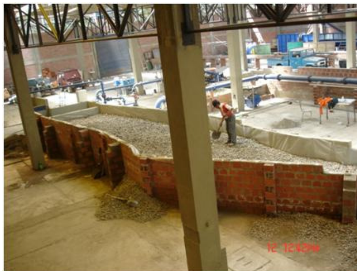
Figura 4. Construcción del lecho del modelo
