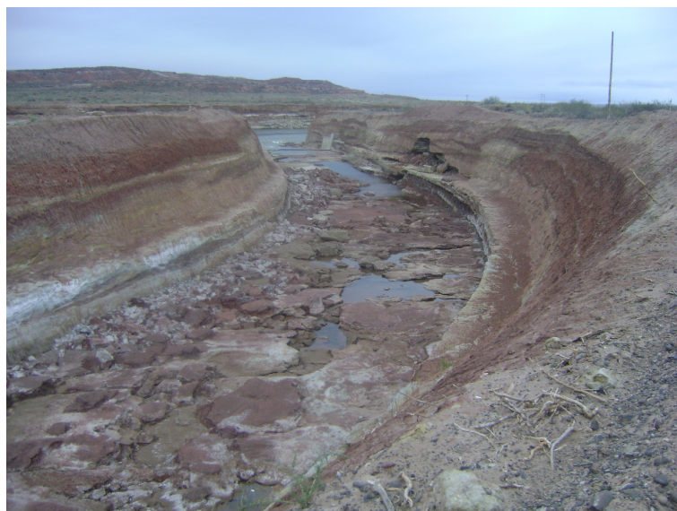
Figura 10.- Vista del canal tras su operación.
