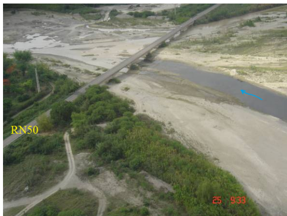
Figura 16.- Puente RN50 – Sin Obra – Tomado desde Aguas Arriba.
