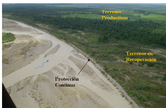
Figura 14.- Protección Continua – Margen Derecha.
