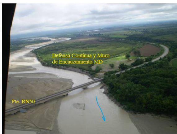
Figura 18.- Puente RN50 – Con Obra – Tomado desde Aguas Abajo - MD.
