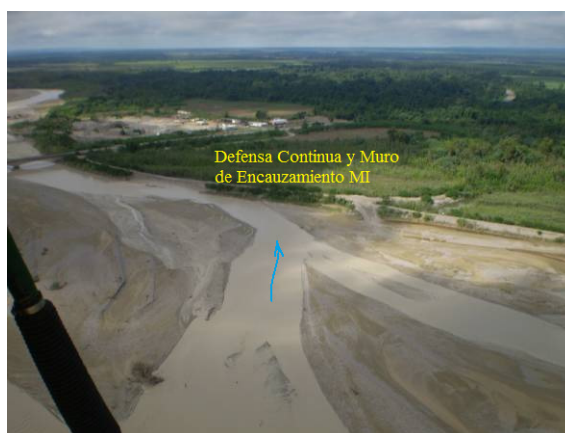
Figura 19.- Puente RN50 – Con Obra – Tomado desde Aguas Arriba - MI.
