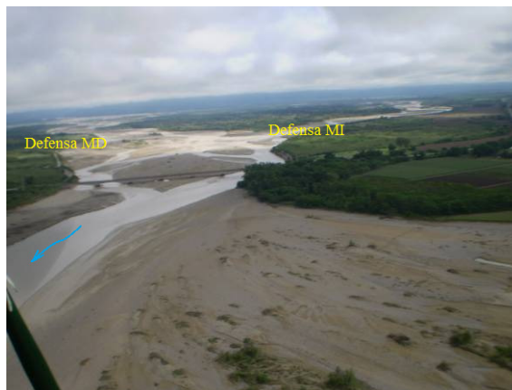
Figura 17.- Puente RN50 – Con Obra – Tomado desde Aguas Abajo.
