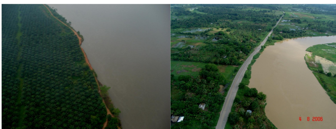
Figura 20.- Ejemplos de lo que no se debe hacer, plantación de palma y una vía importante directamente sobre la orilla del río.
