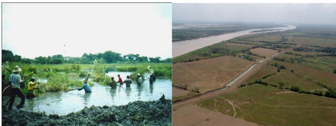
Figura 19.- Ejemplos de lo que se debe hacer, relimpia en la ciénaga de San Rafael y corredor inundable con aprovechamiento restringido sobre la margen izquierda del río Cauca en el municipio de Achí, obras de Cormagdalena
