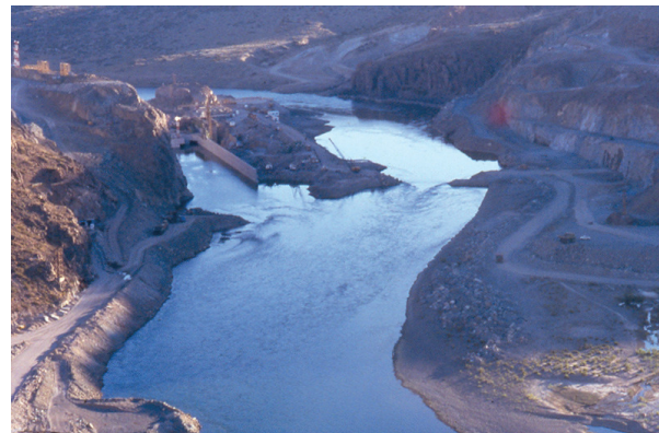
Fotografías 3 y 4: Modelo y prototipo del desvío del río Limay en Piedra del Águila
