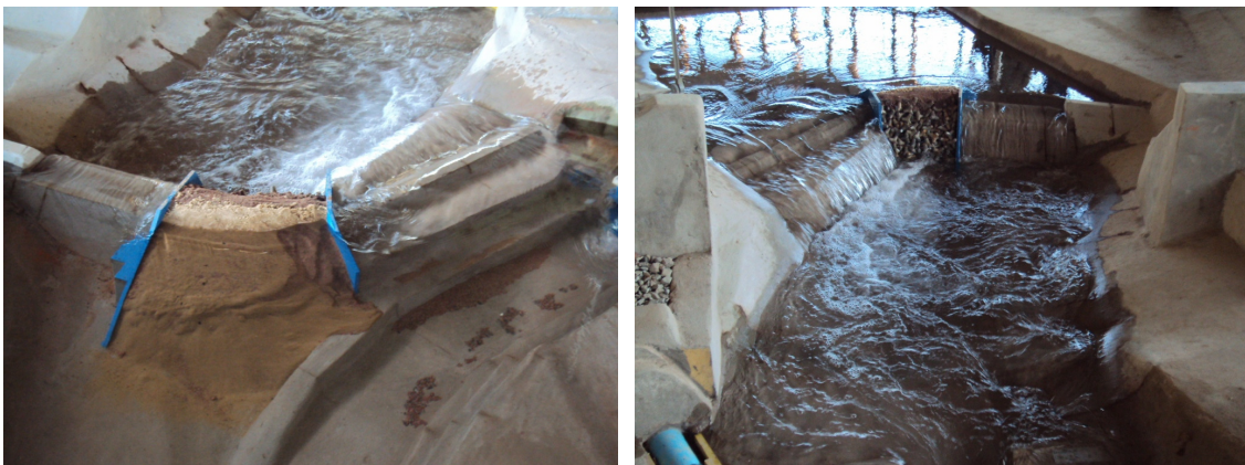
Fotografías 10 y 11: Cierre Bío Bío – Fase final de cierre – Q de verificación = 4100 \text{ m}^3/\text{s} .
