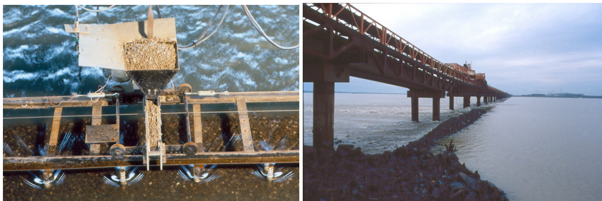
Fotografías 5 y 6: Modelo y prototipo de parte final del cierre del Brazo Principal en Yacyretá
