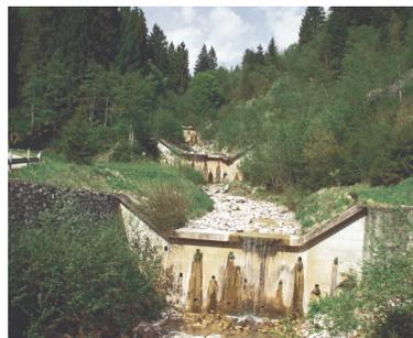
Figura 1.- Obras de sistematización de torrentes.
