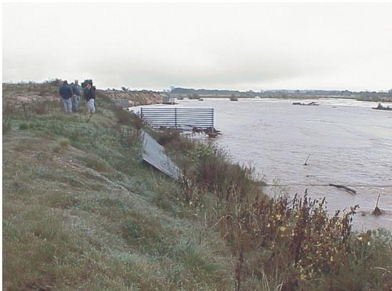
Figura 1: Destape del poliducto REPSOL-YPF (der) y protección en margen con pantalla metálica (izq).
