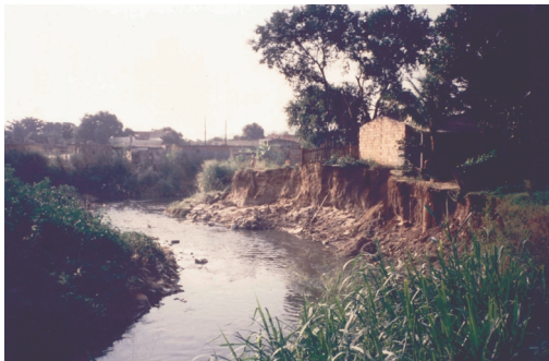
Figura 1.- Erosión en el Río Botas, afluente del Río Iguazu, Provincia del Río de Janeiro, Brasil
