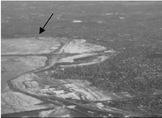
Figura 2.- Vista aérea del terraplén Irigoyen. Su rotura -flecha- permitió el ingreso repentino de agua en la noche del 29/04
