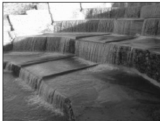
Figura 5.- Obra en funcionamiento
