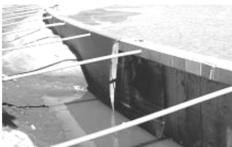
Figura 2.- Ejecución del pleno drenante
