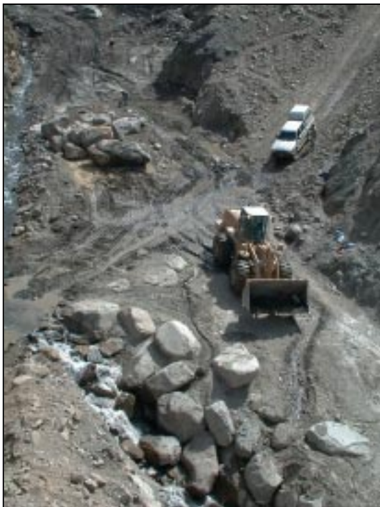
Figura 4.- Enrocado ciclópeo con junta tomada con suelo cemento
