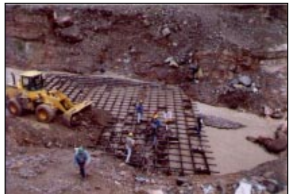
Figura 5.- Protección de lecho con reja de acero estructural
