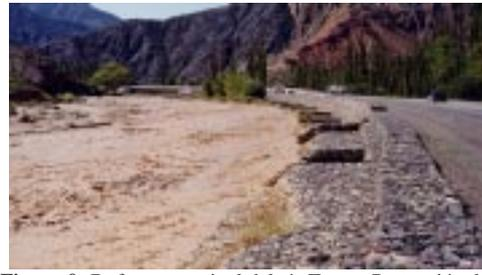
**Figura 9.-**Defensa marginal del río Toro – Protección del terraplén de la ruta Nac. 51 con botadores de refuerzo.
