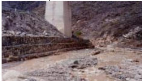
**Figura 6.-**Defensa marginal del río Toro – Protección de las pilas centrales del puente ferroviario
