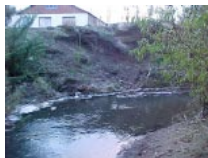
Figura 2.- Construcción en margen izquierda.
