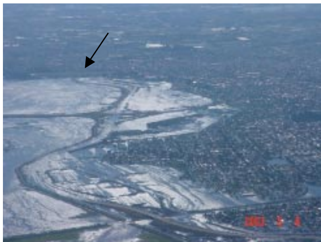
Figura 2.- Vista aérea del terraplén Irigoyen. Su rotura –flecha– permitió el ingreso de agua en la noche del 29/04
