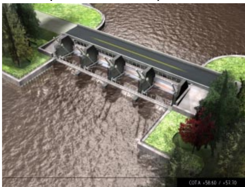
Figura 1.- Obra de Control con cuatro compuertas
