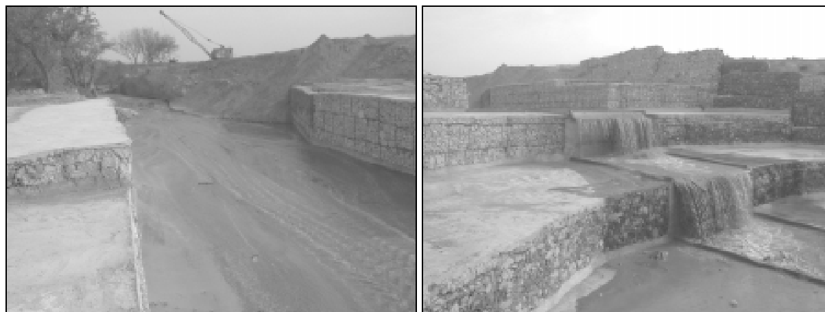
Figura 19: Reparación realizada en el canal de aducción a la obra.
