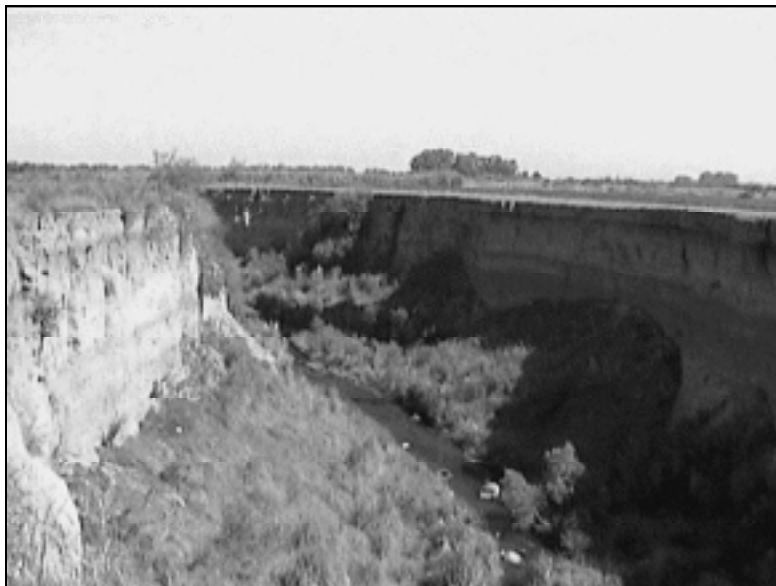
Figura 3: Vista del el cauce hacia aguas abajo desde la cabecera de cárcava (Febrero de 2001).
