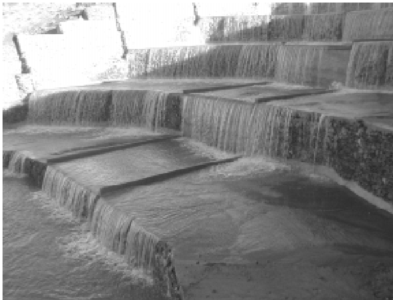
Figura 13: Obra en funcionamiento para caudales bajos.
