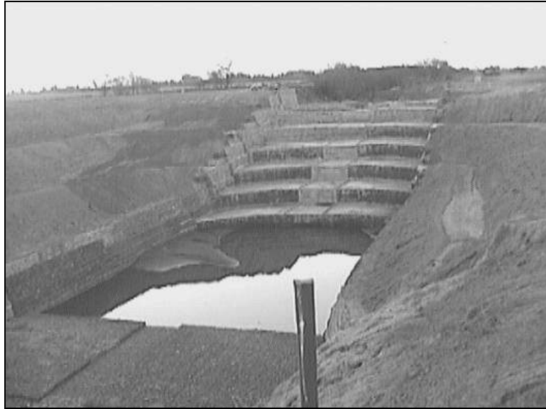
Figura 12: Obra concluida, Junio de 2003, (cada salto vertical tiene una altura de 2,3 m).
