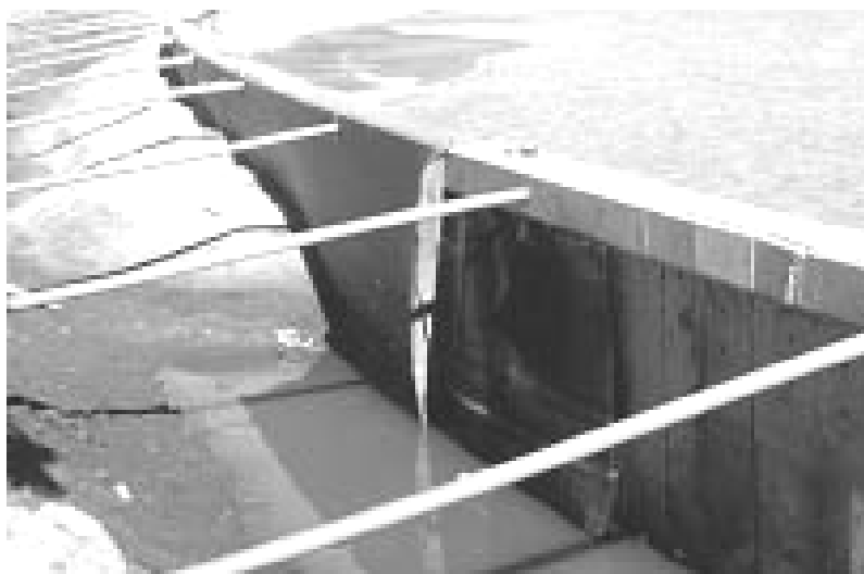
Fig. 5 Ejecución del pleno drenante
