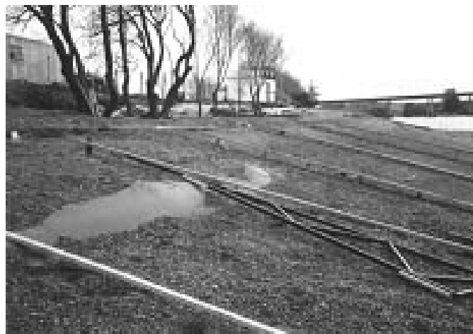
Fig. 2 Manto drenante y perfilado del talud
