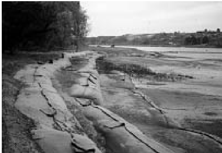
Fig. 1 Geotubos de geotextil no tejido
