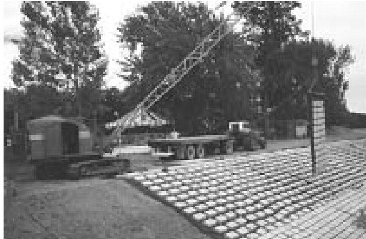
Fig. 3 Colocación de mantas de revestimiento
