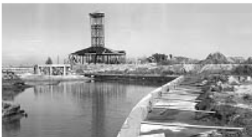
Fig. 6 Vista obra terminada
