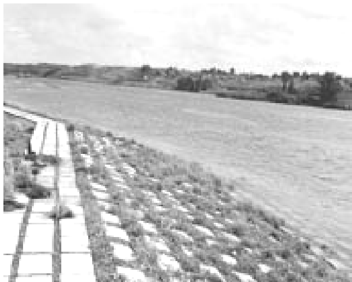
Fig. 4 Vista de la obra terminada
