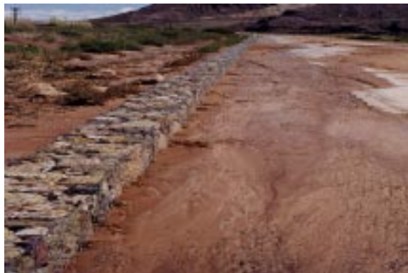
Figura 8.- Defensa marginal del río Toro – Protección del terraplén de la ruta Nac. 51
