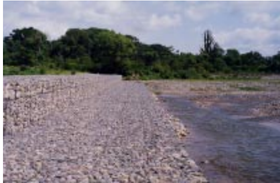
Figura 11.- Defensa marginal del río Wierna – Protección de La Caldera.
