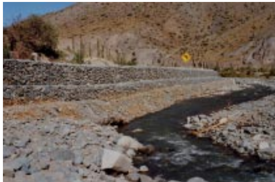
Figura 5.- Defensa marginal del río Toro – Protección del terraplén de la ruta Nac. 51
