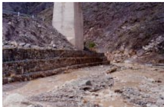
Figura 6.- Defensa marginal del río Toro – Protección de las pilas centrales del puente ferroviario
