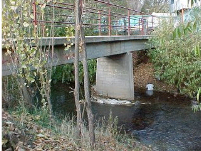
Figura 5.- Puente de hormigón.
