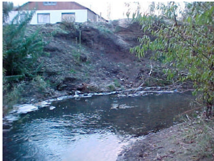
Figura 3.- Construcción en margen izquierda.
