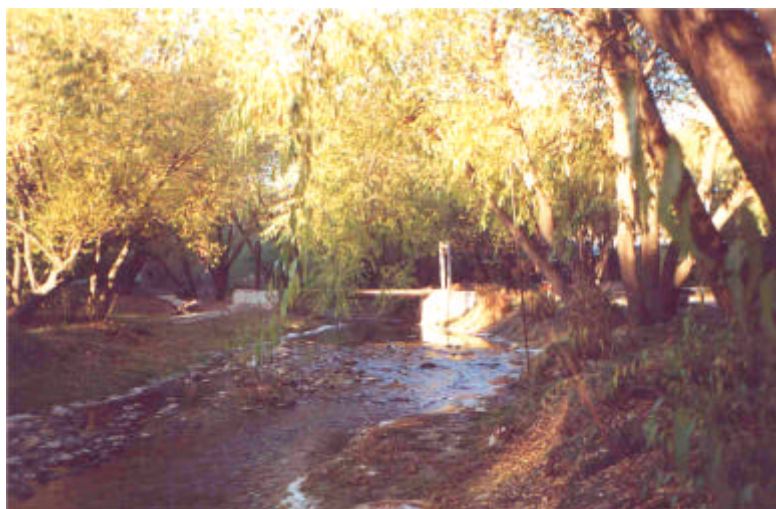
Figura 4.- Contracción causada por pasarela interpuesta en el cauce.
