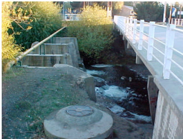
Figura 6.- Puentes de hormigón (antiguo con cañería y nuevo).
