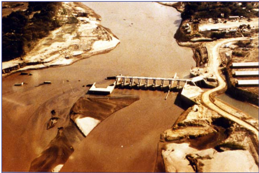
Figura 2.- Falla de la presa Los Ejidos (1983), río Piura , Perú.
