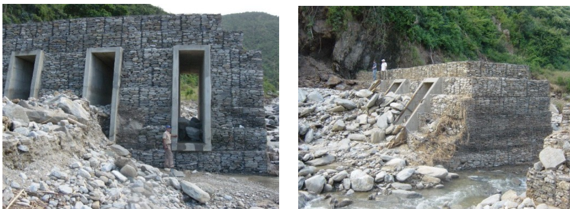
Figura 8. Vista desde aguas arriba de la acumulación de sedimentos en las ventanas de la Quebrada Camuri Chico.
