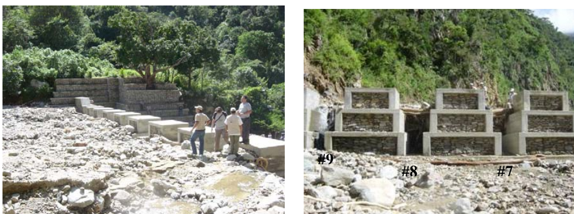
Figura 11. Vista del vaso sedimentado de la Presa #2 en Quebrada El Cojo (izquierda) y de la obstrucción de las ranuras numeradas 7, 8 y 9 (derecha). Fotos tomadas en Febrero del 2005, unos pocos días después de las lluvias torrenciales.
