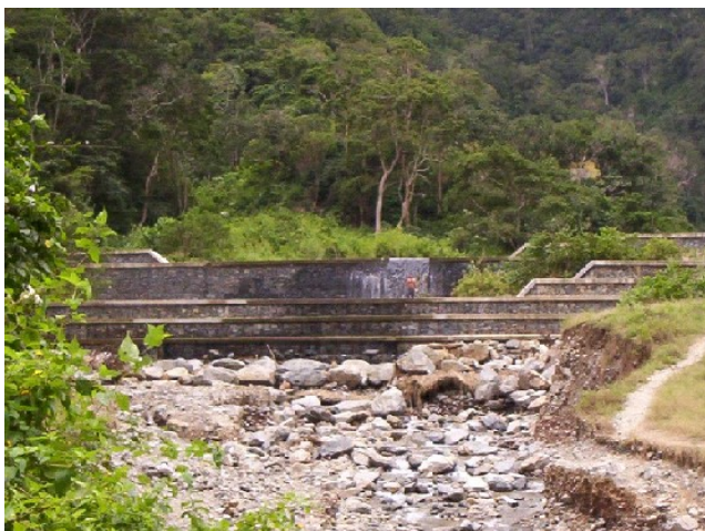
Figura 6.- Vista desde aguas abajo de la Presa # 2 en Quebrada Piedra Azul. Foto izquierda tomada en Marzo 2005 y foto derecha en Abril 2007, observándose descenso del lecho de unos 3 m aproximadamente al pié del contradique.
