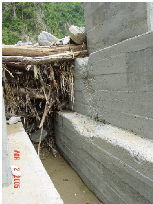
Figura 12. Vista frontal de la ranura #8 en la Presa #2 de la Quebrada El Cojo, mostrando la obstrucción para el año 2005 y para el año 2007.
