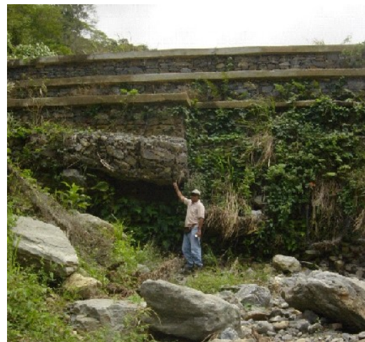
Figura 6.- Vista desde aguas abajo de la Presa # 2 en Quebrada Piedra Azul. Foto izquierda tomada en Marzo 2005 y foto derecha en Abril 2007, observándose descenso del lecho de unos 3 m aproximadamente al pié del contradique.
