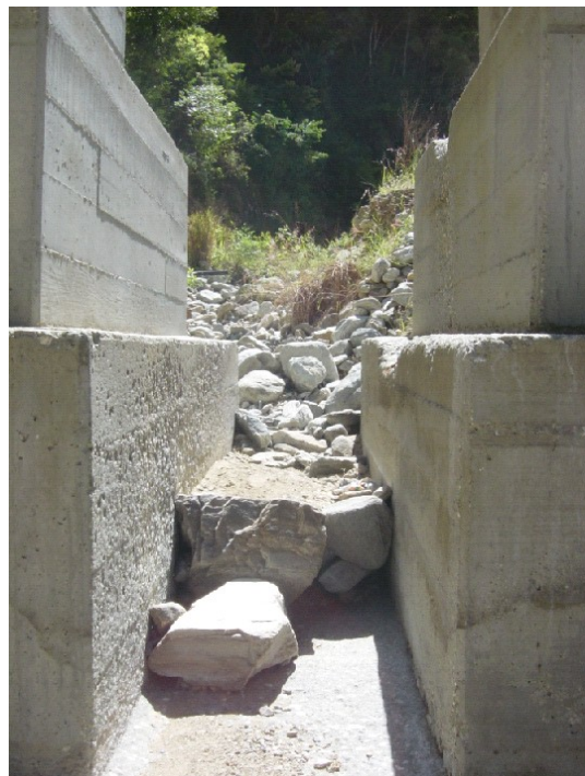
Figura 12. Vista frontal de la ranura #8 en la Presa #2 de la Quebrada El Cojo, mostrando la obstrucción para el año 2005 y para el año 2007.
