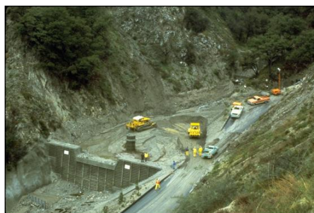
Figura 7. Limpieza de una represa
