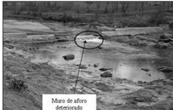
**Figura 4.-** Muro de aforo de Barrio El Canal, en el Río San Antonio (cuenca del dique San Roque. Fotografía del Ing. Cattalini). (Colladón y Caamaño Nelli, 2006).
