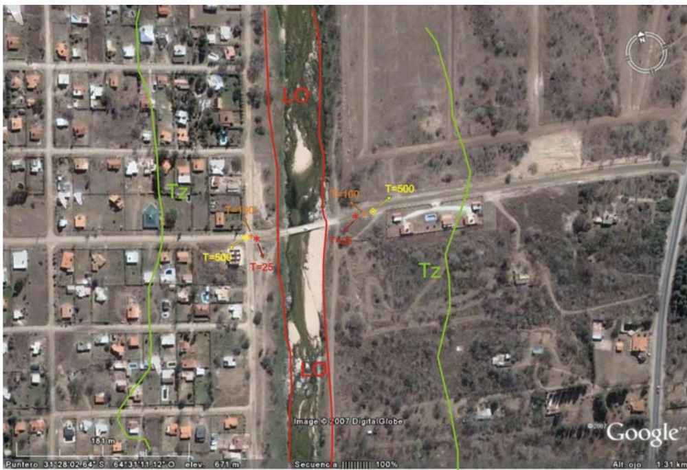
Figura 6 -Sección San Antonio-vado, indicando el trazado del LO, las Tz y los puntos que alcanzarían crecidas de recurrencia 25, 100 y 500 años.
