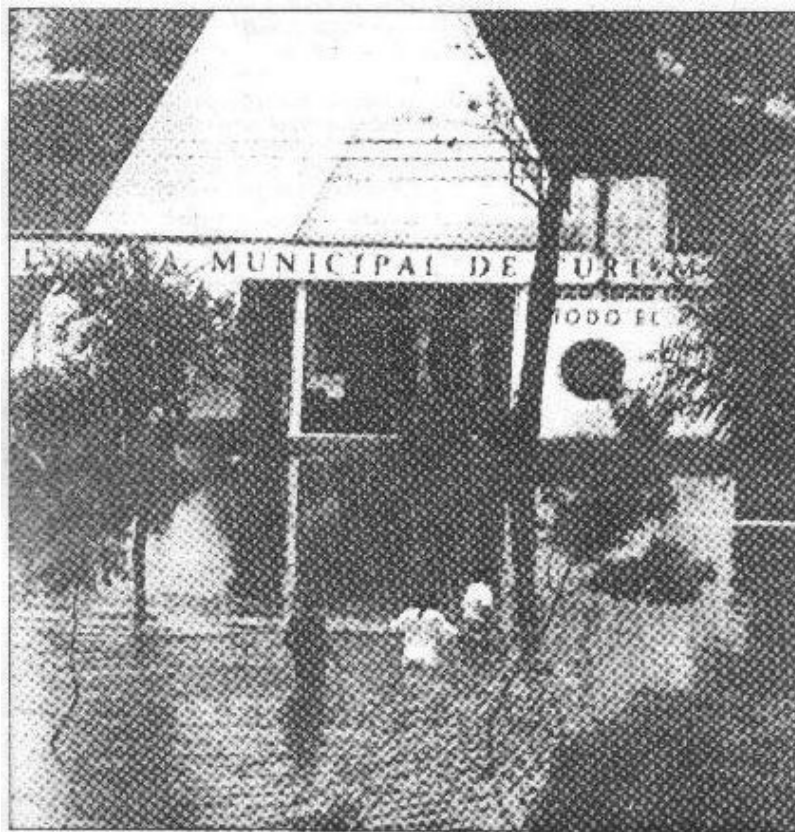
El avance del agua sobre la ciudad de Carlos Paz quedó de manifiesto en la zona donde está ubicada la Secretaría de Turismo.
