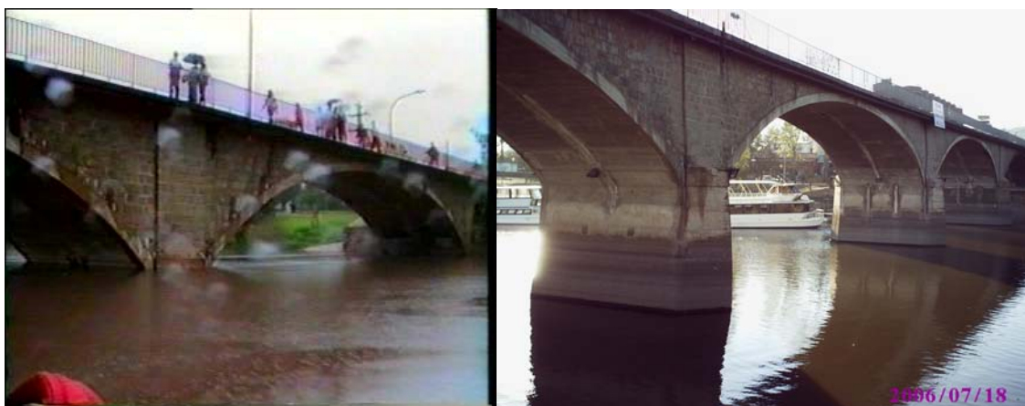
Figura 8: Puente carretero, Av Uruguay (1992 izquierda y 2006 derecha).
