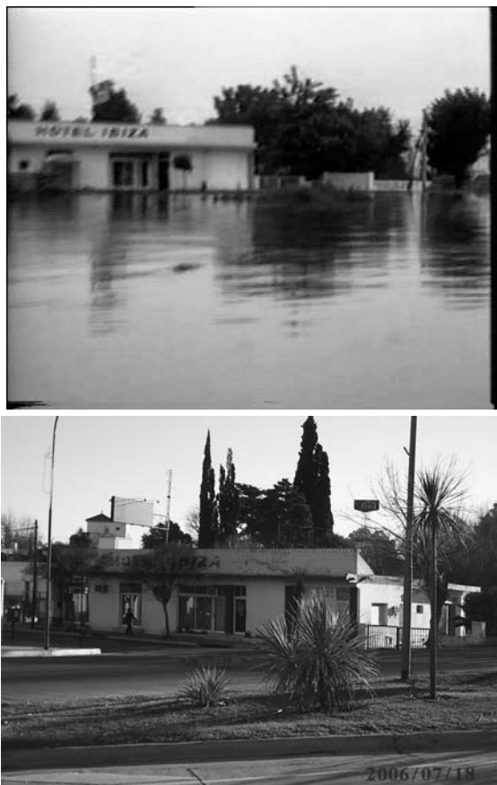
Figura 2.- El hotel Ibiza en la cabecera del puente Cassaffouth, (1992 arriba y 2006 abajo).
