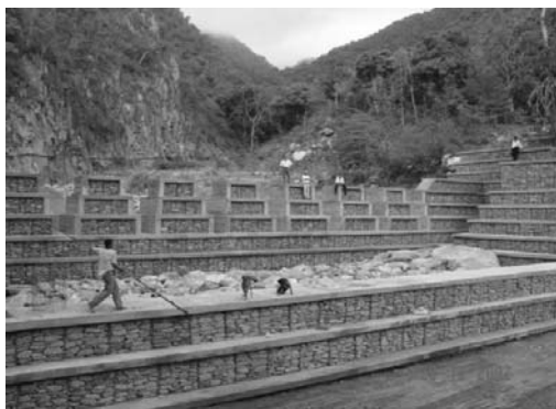
Figura 3.- Vista frontal de la presa #2 en El Cojo
