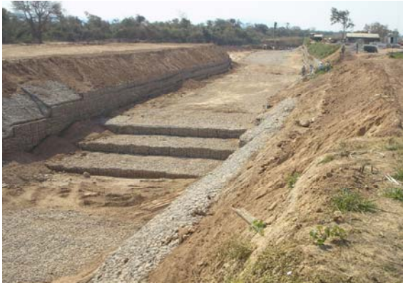
Figura 3.- Quebrada de Galarza – Obra de encauzamiento y Escalera de Gaviones
