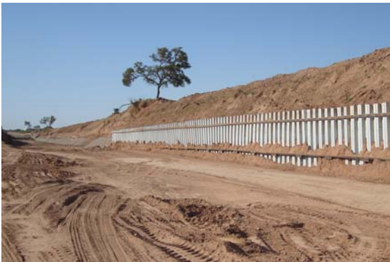
Figura 4.- Quebrada de Galarza – Protección Longitudinal
