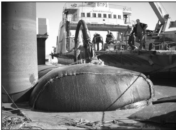
Figura 3.- Relleno de GeoTubo®.
