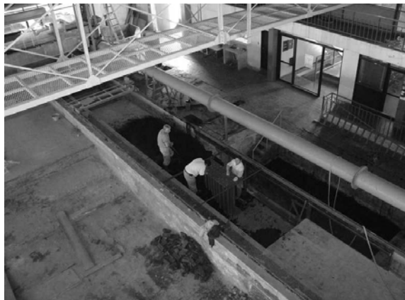
Figura 1.- Montaje de estructura y preparación del fondo móvil
