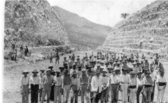
Figura 1 – Situación de la excavación original 1927
