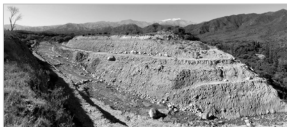
Figura 4 - Situación de la ejecución de obra - 2008
