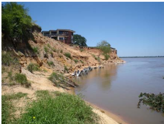
Figura 4.- Procesos erosivos en la zona del hotel de Turismo de Empedrado.
