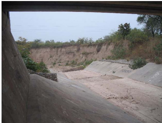
Figura 15.- Arroyo Zanja Honda. Vista hacia aguas abajo desde la sección del puente sobre la R.N. 34. Se observa el descenso del nivel del lecho en la sección de restitución al cauce natural aguas abajo del puente.
