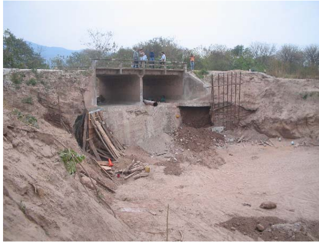
Figura 20.- Arroyo NN ubicado al norte de A° Zanja Honda y al sur del A° Yariaguarenda. Fotografía tomada desde la margen derecha aguas abajo de la alcantarilla cajón de dos celdas sobre la R.N. 34. Nuevamente se observa un proceso de degradación del lecho y erosión retrógrada que ha generado una diferencia de nivel entre la cota del fondo del arroyo y la platea de la alcantarilla del orden de 4 metros. Se observan vestigios de obras precarias en la zona pero se desconoce si este tema ha sido abordado por parte de la DNV para instrumentar medidas de protección y control de la erosión al pie de la platea ante la inminencia de la temporada de lluvias y la situación de riesgo potencial de la obra.
