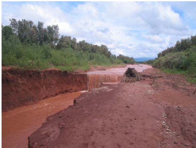
Figura 23.- Arroyo Tortugas. Vista hacia aguas arriba. Puede observarse el importante proceso de cárcavamiento a que está sometido este curso.
