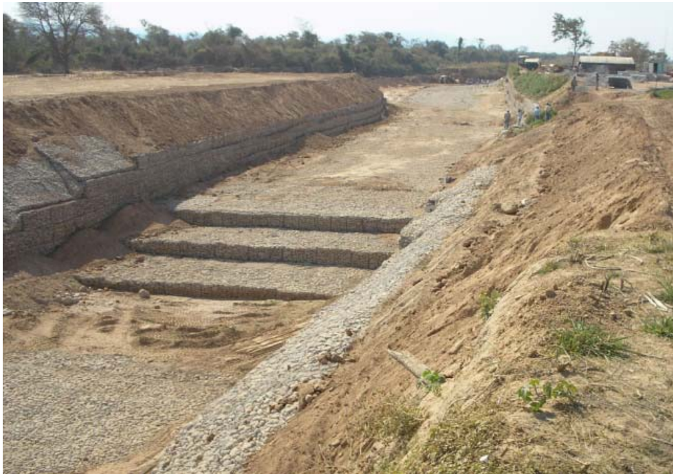
Figura 5.- Quebrada de Galarza – Obra de encauzamiento y Escalera de Gaviones
