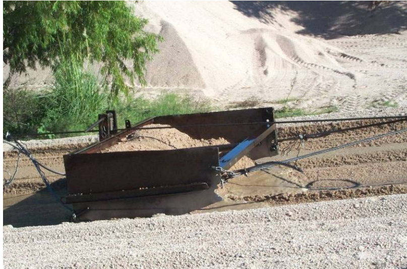
Figura 5.- Extracción de arena del cauce con medios mecánicos
