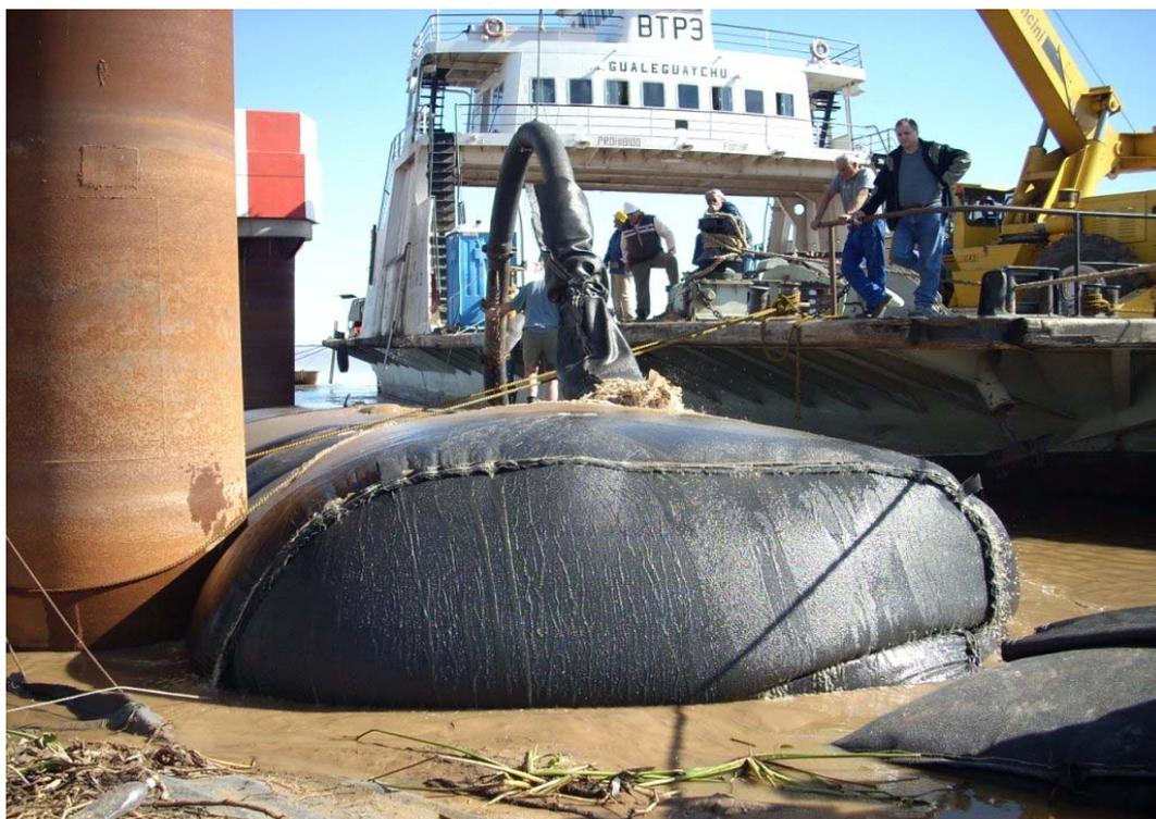
**Figura 9.-** Relleno de GeoTubos<sup>®</sup>.
