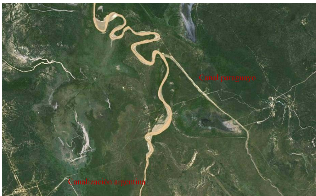
Figura 3.- Comienzo de obras de encauzamiento en Argentina y Paraguay.
