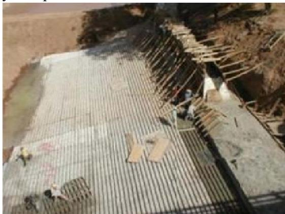
Para el resto de la costa, se proyectaron espigones formados por pilotes metálicos empotrados en el fondo del río y placas de hormigón armado que cierran frontalmente el espigón. Estas placas se apoyan en estructuras metálicas colocadas entre pilotes y empotradas en el fondo.
