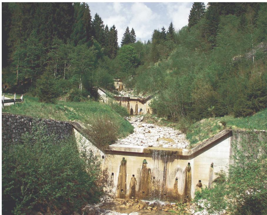
**Figura 1.-** Obras de sistematización de torrentes.
