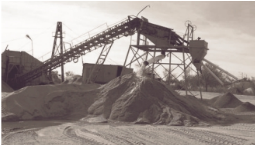
Figura 1.- Extracción de áridos en margen izquierda del Río IV.
