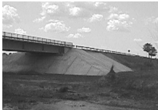
Figura 4: Revestimientos sobre talud conformado y estable
