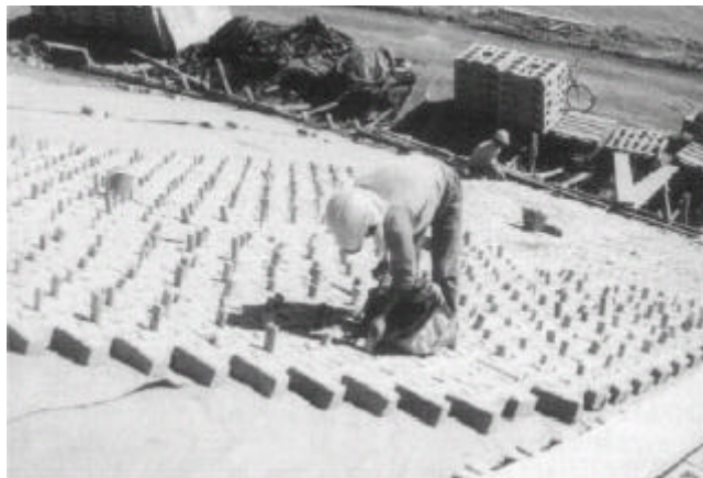
Figura 8: Toma de juntas con arena-cemento de un revestimiento de bloques intertrabados
