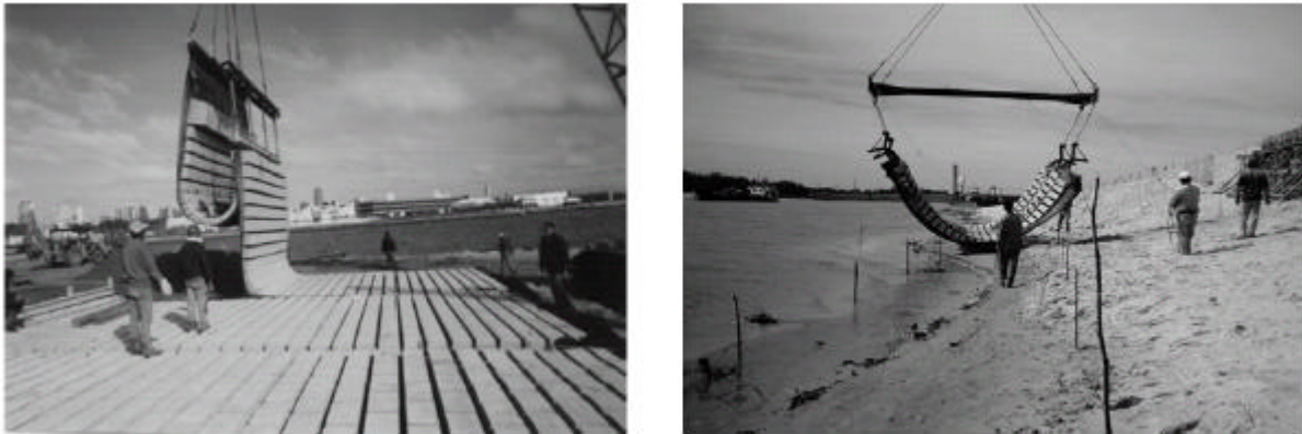
Figura 14: Instalación de revestimientos
