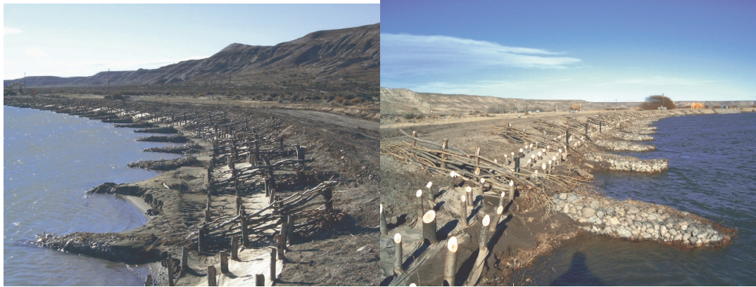
Figura 5.- Obra de estabilización con Gaviones y aplicación de “Técnicas Biológicas”
