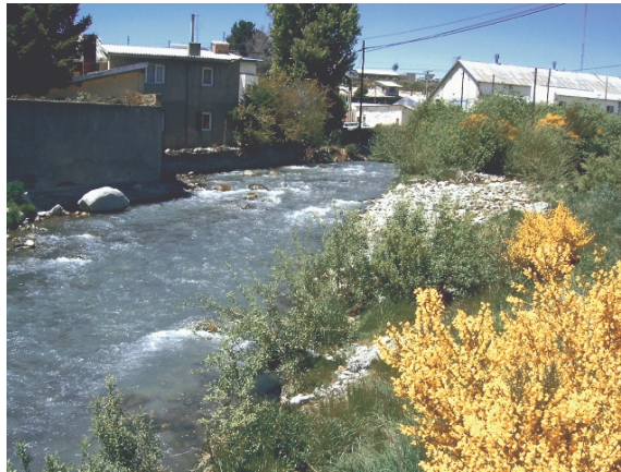
Figura 9.- Sector erosionado de margen derecha con afectación de inmuebles
