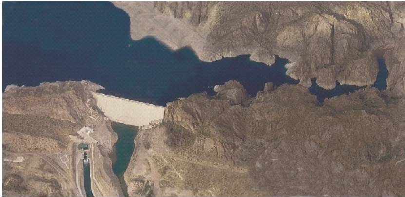
Figura N° 1 – Presa y obra de toma (vista aérea)
