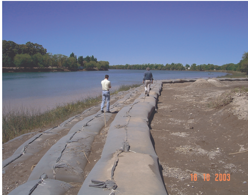
Figura 5 Conformación de un dique con los sacos de geotextil para la contención del material de relleno de la ribera y la estabilización de la margen.
