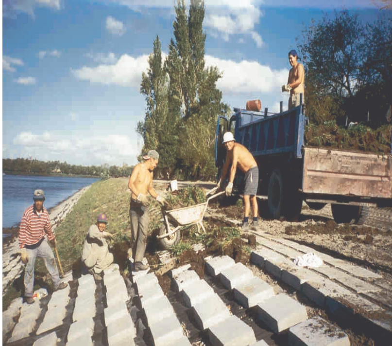
Figura 11. Trabajos de colocación de panes de césped “tepes” entre los espacios de los bloques de hormigón.
