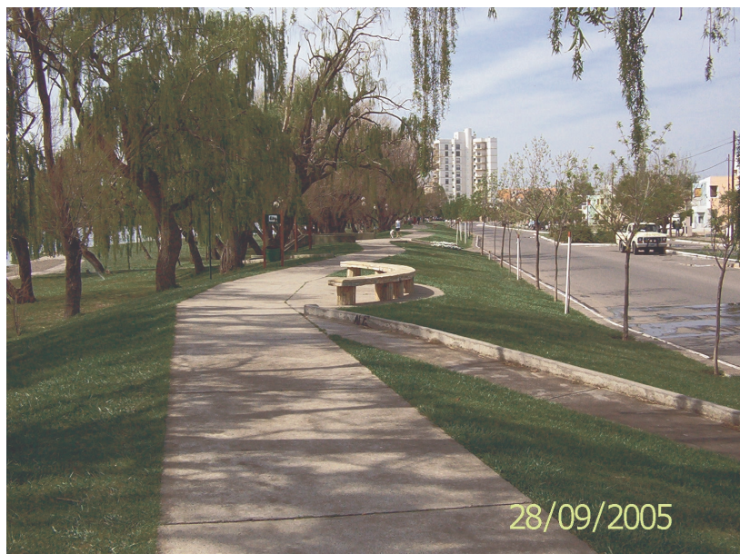
Figura 2 Vista del terraplén finalizado la obra: con taludes vegetalizados, coronamiento con vereda de hormigón, rampas de acceso y asientos revestidos con piedra tipo pórfidos.
