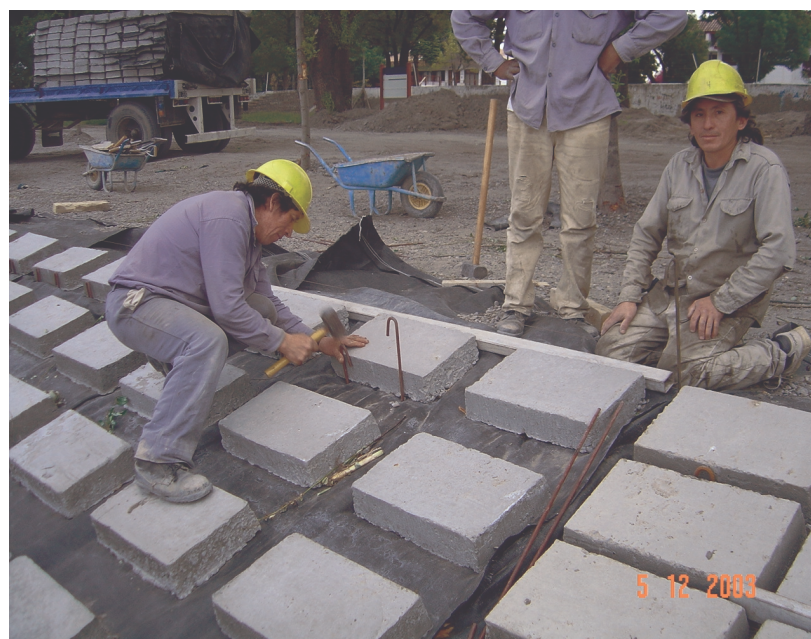
Figura 10 Trabajos para la fijación de los bloques de hormigón a la manta geotextil.
