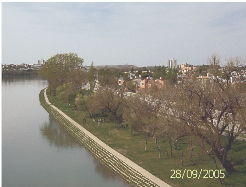
Figura 12 Vista de la ribera finalizada la obra de estabilización de la margen
