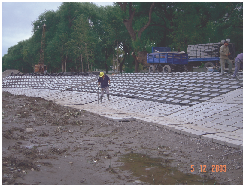
Figura 6 Colocación, sobre el talud conformado, de mantas de geotextil con lastre de bloques de hormigón para completar la estabilización de la margen.
