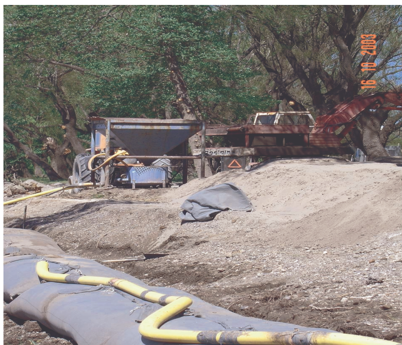
Figura 3. Relleno de contenedores de geotextil y área de ribera mediante el bombeo de gravas y arenas extraídas de embanques del río
