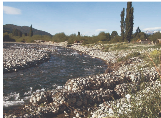
Figura 7: Espigón sobre margen izq.
