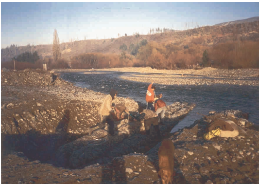
Figura 6: Construcción de espigón
