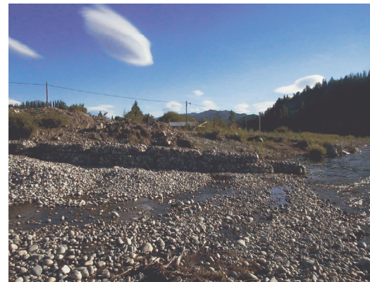
Figura 5: Espigón construido
