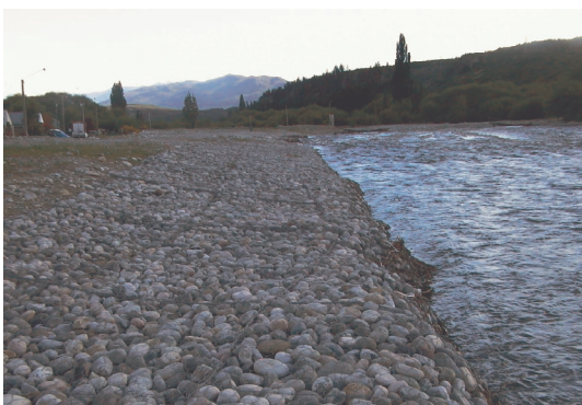
Figura 14: defensa continua con colchonetas
